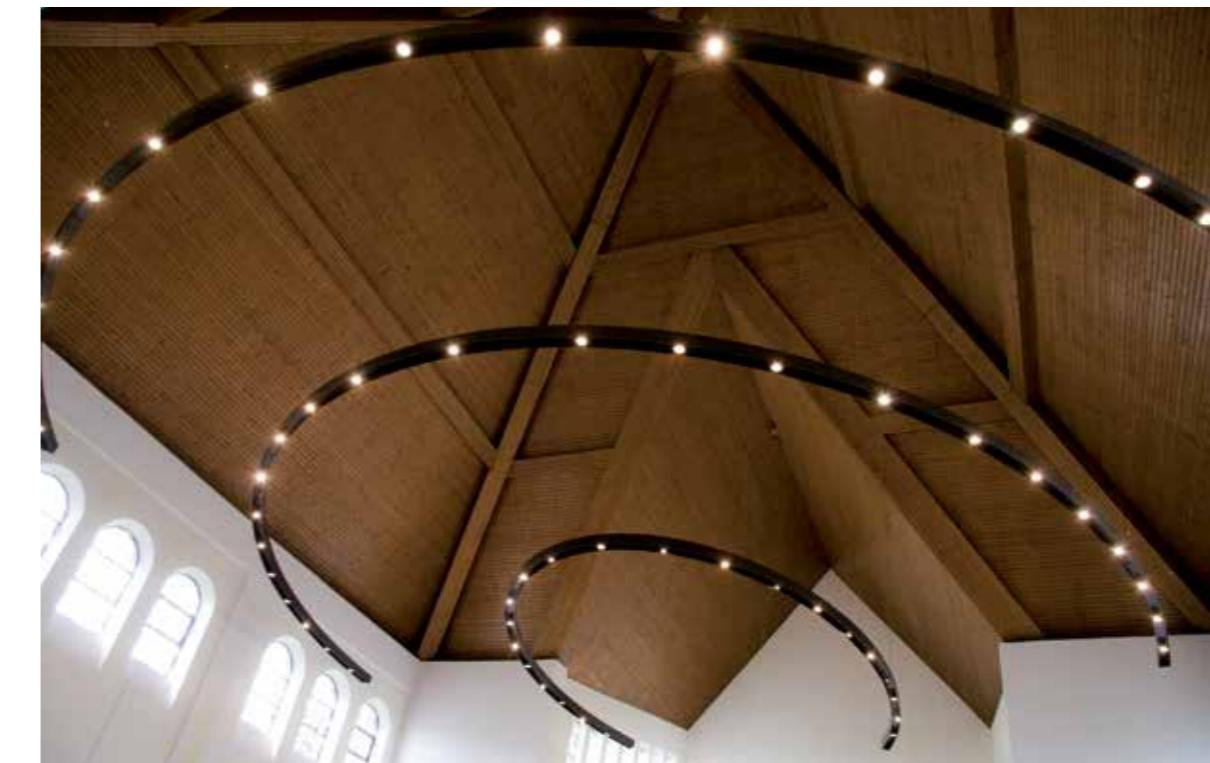
Die Ringleuchten auf Halogen-Basis strahlen die Kirche gleichmäßig aus. Sie wurde in mehreren Teilen angeliefert und vor Ort montiert. Die größte der drei Ellipsen hat einen Umfang von 25 Metern.
